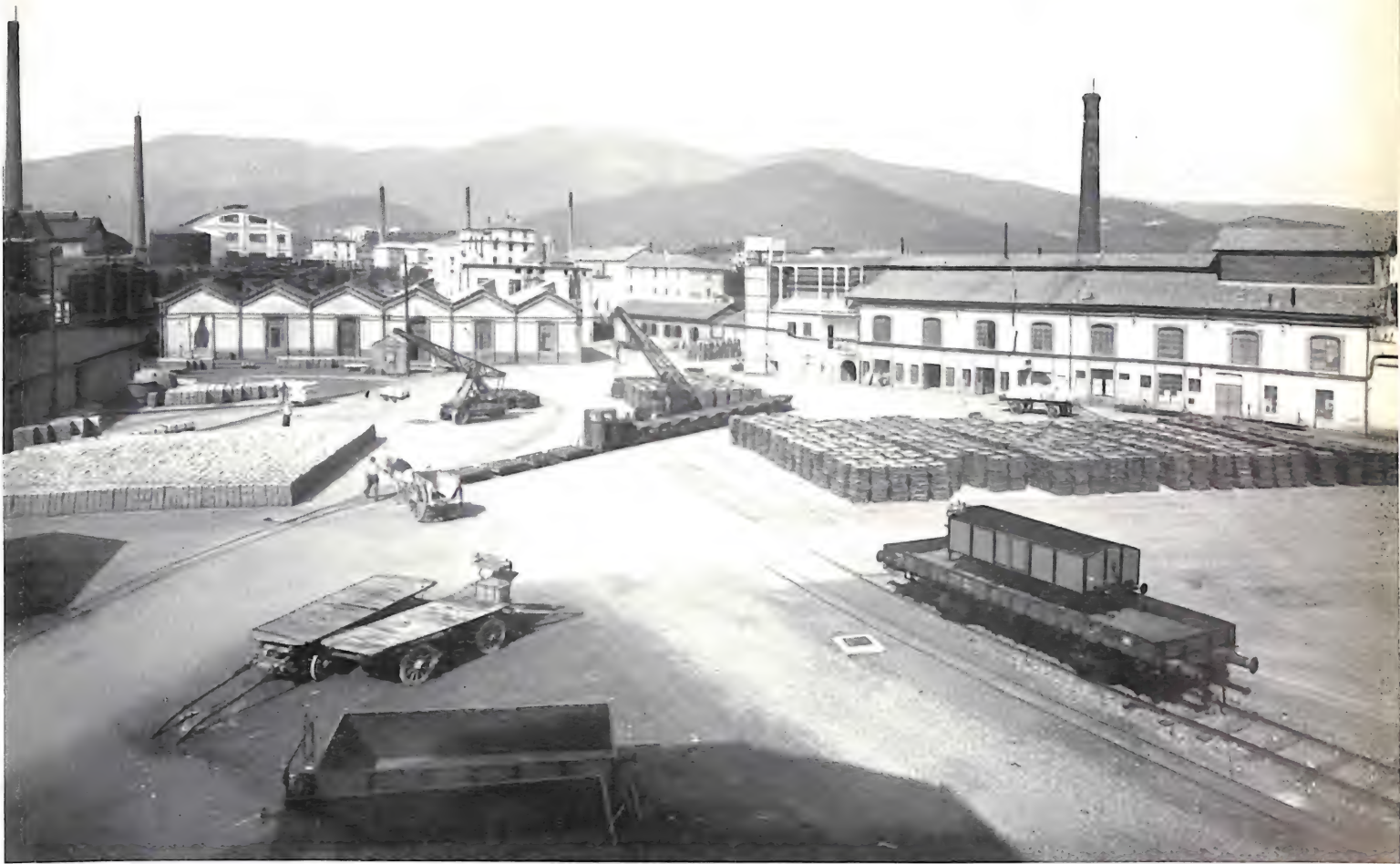
Vado Ligure - Piazzale deposito e smistamento dei metalli e materiali.
